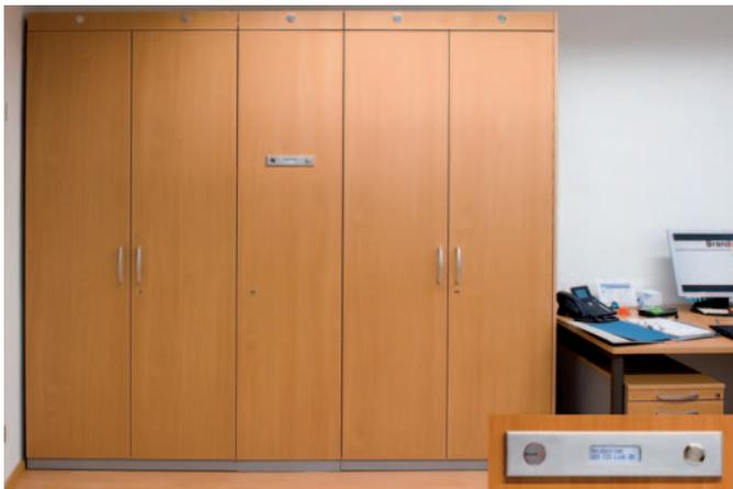
**Bild 2.** Brandexx-aktiv befindet sich im mittleren Schrankelement; die funktional reduzierte Anzeige gibt zu jedem Zeitpunkt Auskunft über den Status des Funkkontakts zum Rauchmelder, zur Brandwarte, den Ladestatus der integrierten Akkus sowie im Auslösefall über den Status der Löschung (Fotos: Brandexx)
